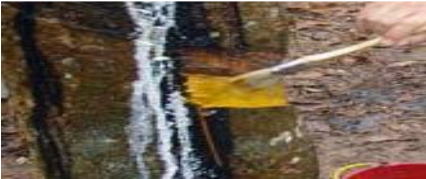
Gambar 5.9. Pengerokan dan Pengolesan Obat Antico F-96
